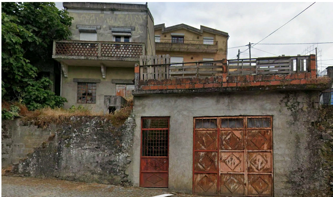
Figura 3. Exemplificação de edifícios degradados – EN 313-2
