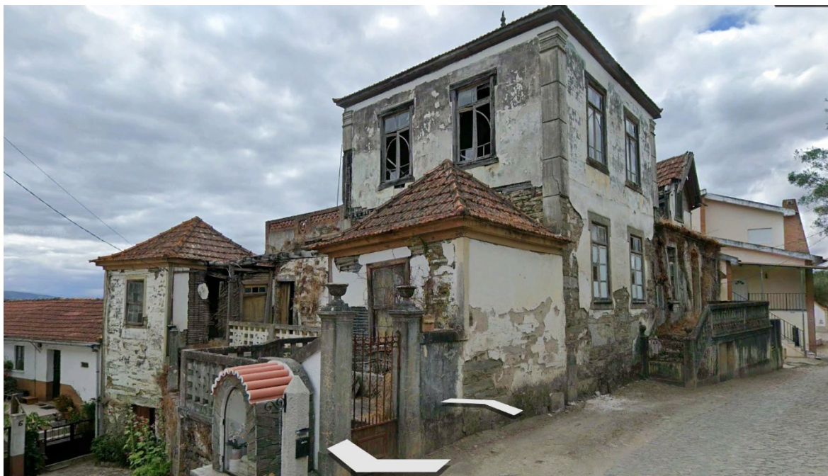
Figura 2. Exemplificação de edifícios degradados – EM 593
