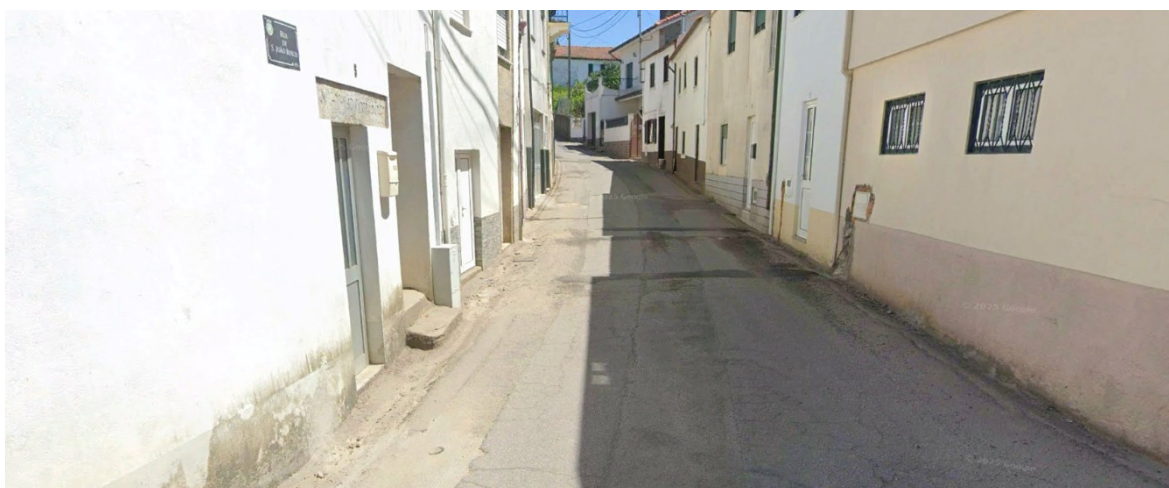
Figura 5. Exemplificação de piso degradado na ARU de Poiares – Rua São João Bosco
