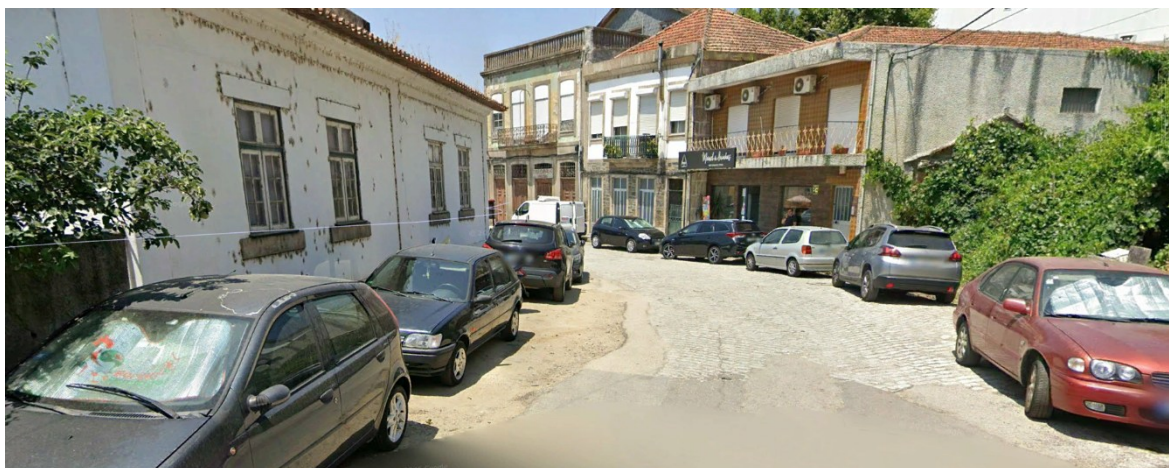
Figura 9. Exemplificação de constrangimentos de disponibilidade de estacionamento na ARU de Peso da Régua e Godim – Rua de São Domingos
