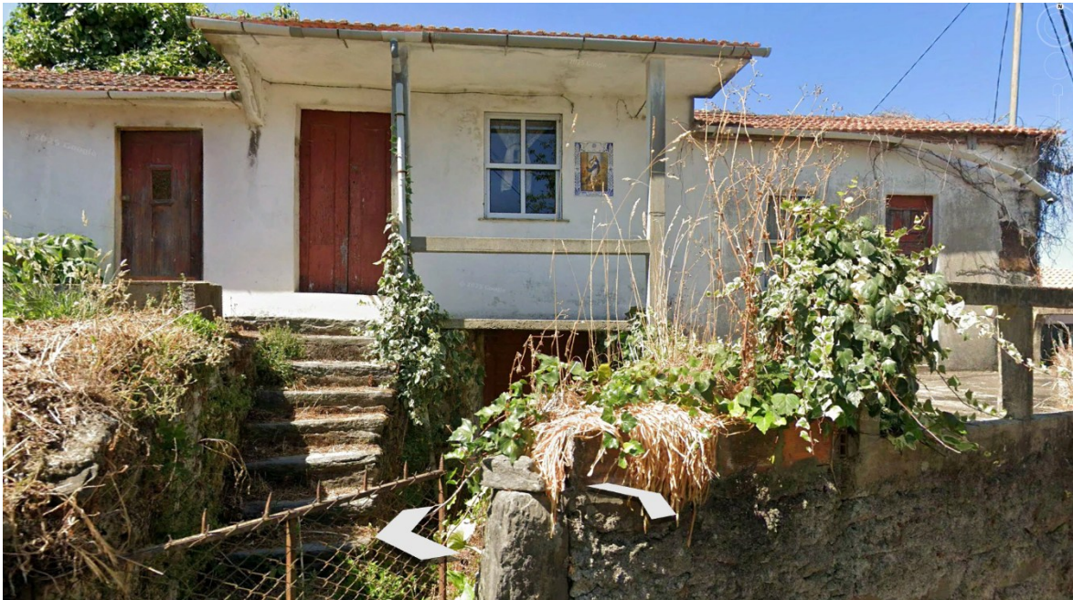
Figura 3. Exemplificação de edifícios com necessidades de reparação
