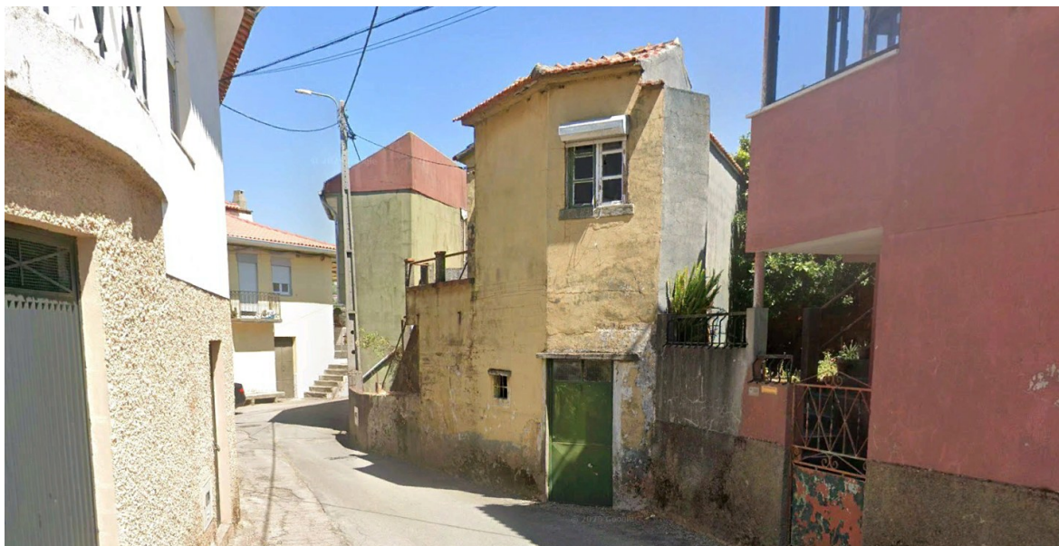
Figura 2. Exemplificação de edifícios degradados
