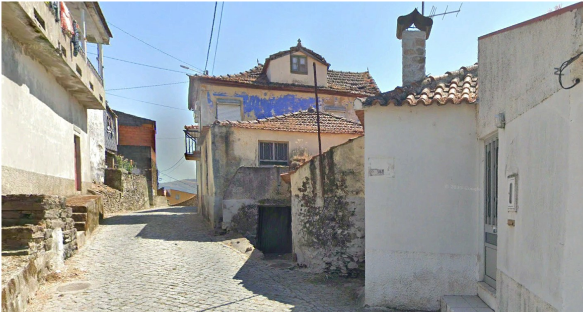
Figura 4. Exemplificação de edifícios degradados – Rua do Miradouro
