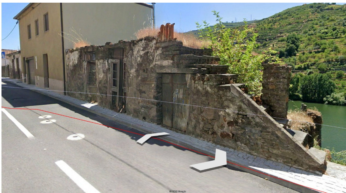
Figura 4. Exemplificação de edifícios degradados – IC 26
