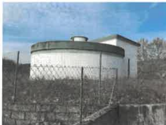
FOTO 2 - RESERVATÓRIO DE BERTELO
