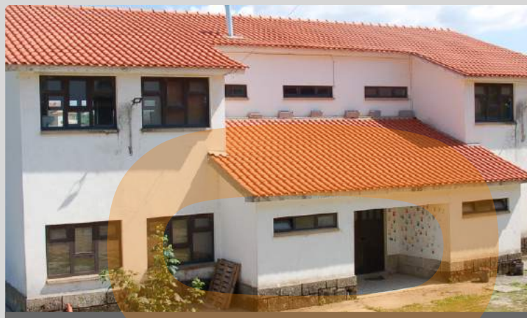
Intervenção no telhado da Escola Primária de Canelas | Canelas
